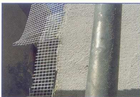
Vue de la trame dans le PRÉPENDUIT
